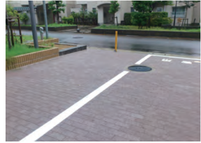
グリーンビズG-ttによる舗装。超保水性性能によって水たまりになりにくい。
