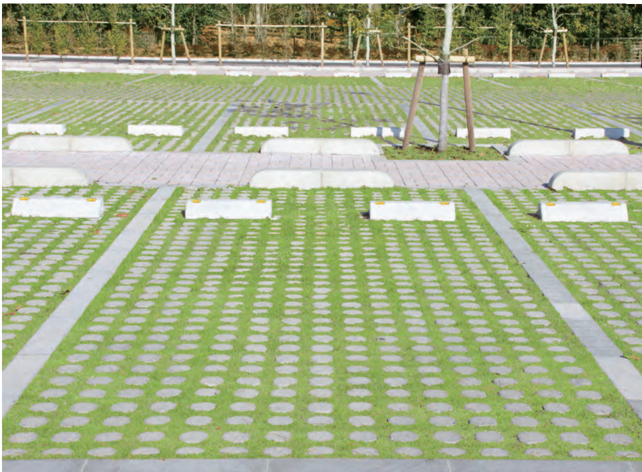
公園内駐車場施工例：公園の緑と調和させながら夏の照り返しを防ぐなど、快適で機能的な駐車スペースに。耐久性に優れるので、車両乗入れに対しても安心です。
