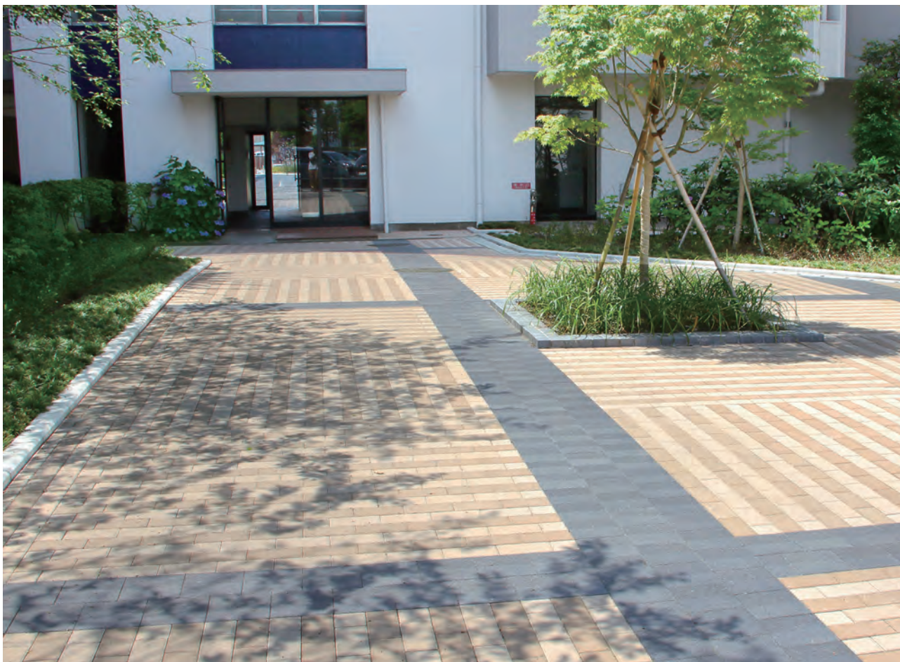
UR久喜中央ハイツ：集合住宅外構。グレー部分のサンシャドウ (P28) との組み合わせで、色の濃淡とスリットの陰影効果によるユニークな表情を演出しています。
