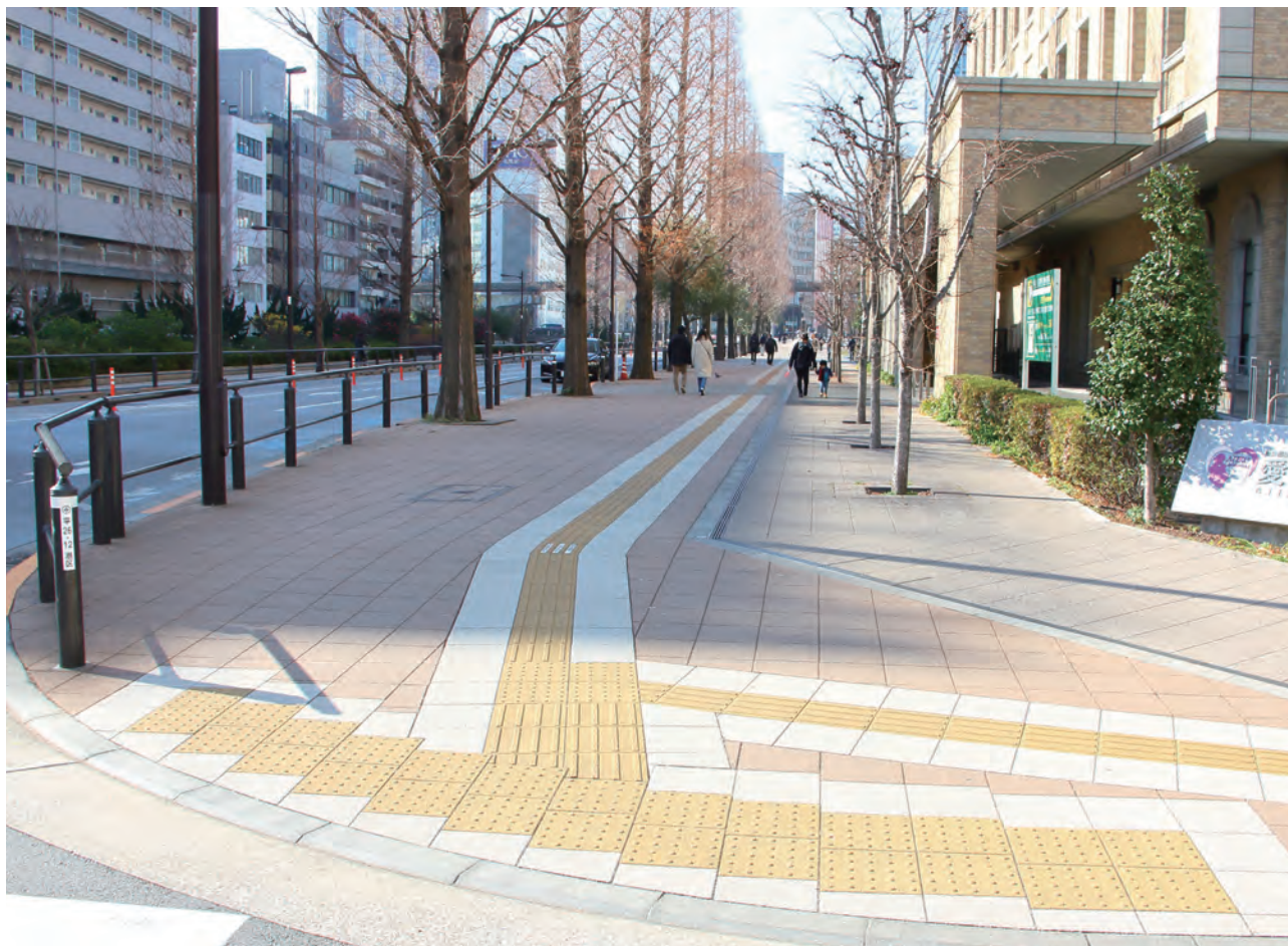
田町歩道：再開発によって整備された芝浦公園と隣接する母子専門病院は、地域の人が集う拠点。ここを囲む歩道は、保水ブロック「ゲイン」で舗装されています。
