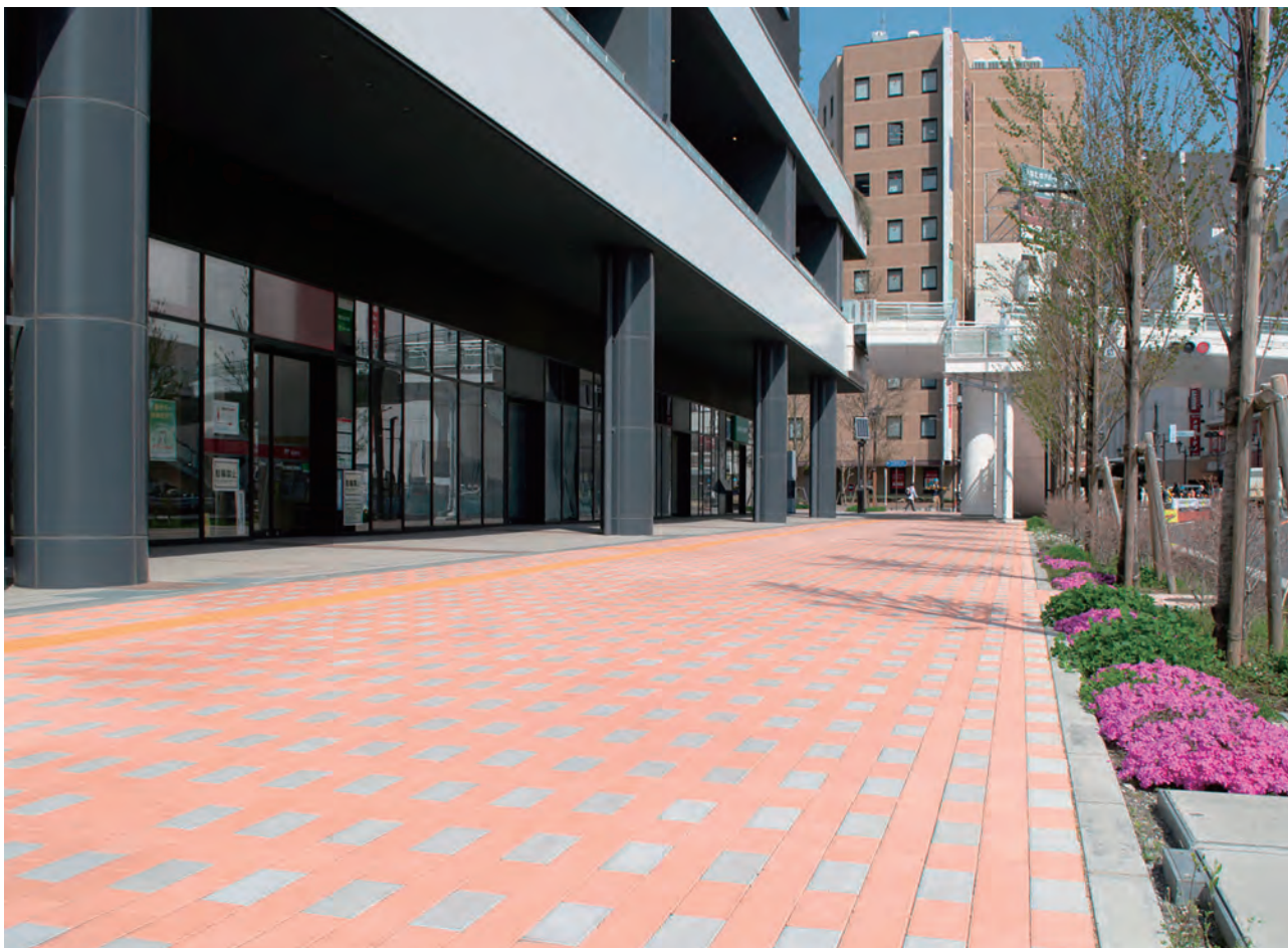
所沢駅西口：所沢駅西口開発計画として、道路の拡幅や歩道空間の整備など、所沢市の玄関口としてのまちづくりに適した機能性舗装材として採用されました。
