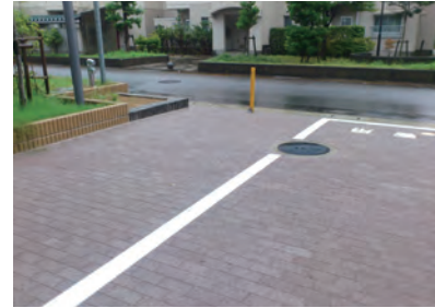
グリーンビズG-ttによる舗装。超保水性によって水たまりになりにくい。
