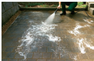
施工イメージ。目地砂表面から泡が出るまで散水。
