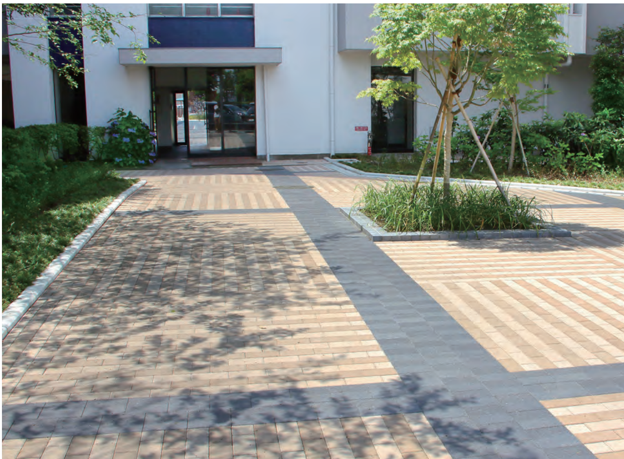
UR久喜中央ハイツ：集合住宅外構。グレー部分のサンシャドウ (P28) との組み合わせで、色の濃淡とスリットの陰影効果によるユニークな表情を演出しています。
