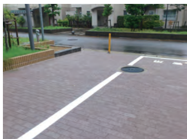
グリーンビズG-ttによる舗装。超保水性によって水たまりになりにくい。
