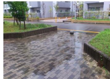
一般的な非透水ブロック舗装。雨水で路面が水浸しに。
