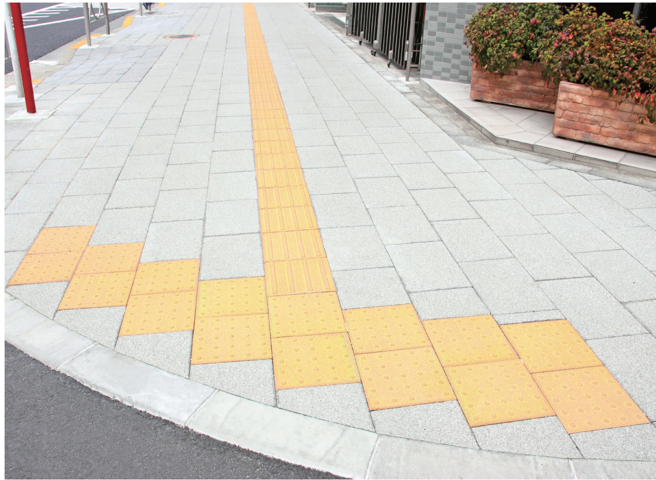
東池袋歩道：機能的に配置された誘導ブロックは、視覚障害者の心強い味方となります。 車いすや杖を利用される方がつまづきにくいよう、目地の凹凸をできるだけ少なくしました。
