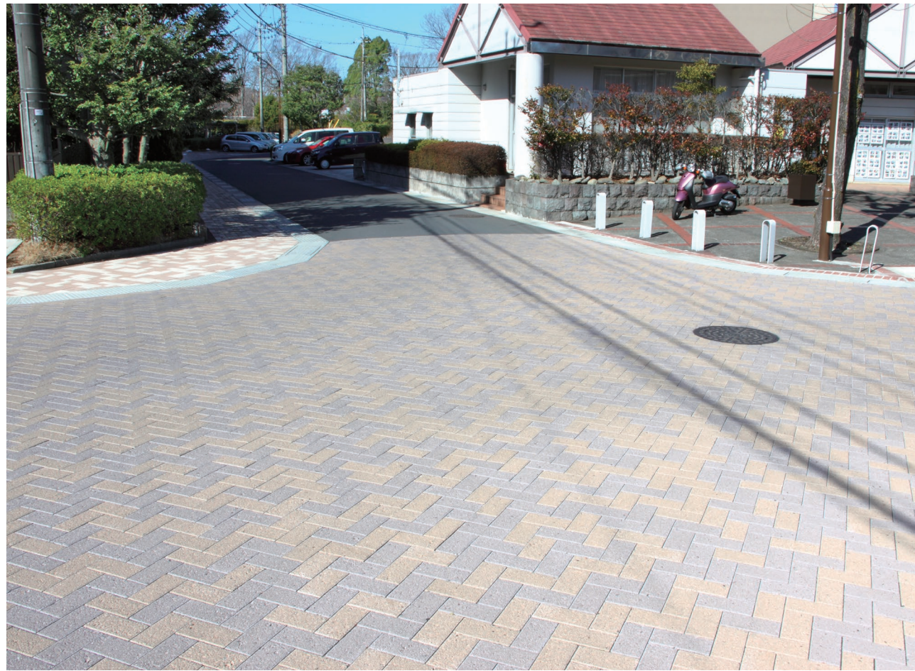
ホームタウン南大沢車道：東京の西部、多摩丘陵に位置する住宅地「ホームタウン南大沢」の車道部分に採用されたミマーレ Aシリーズ。 クラシカルなディテールが落ち着いた街並みに馴染んでいます。
